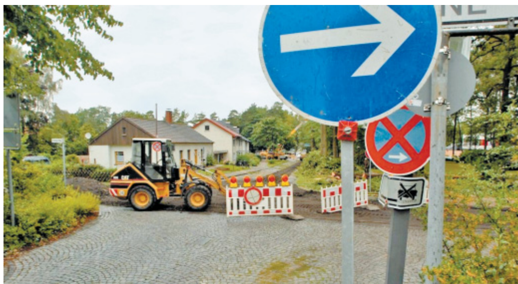
Hier geht's ab sofort nicht mehr geradeaus: Nur noch nach rechts in den Tilsiter Weg. Die Trakener Straße wird bis zum Oktober bis zur Kantstraße ausgebaut. Rechts entstehen neue Parkplätze außerhalb der Straßenfläche. FOTO: JOERN SPREEN-LEDEBUR
